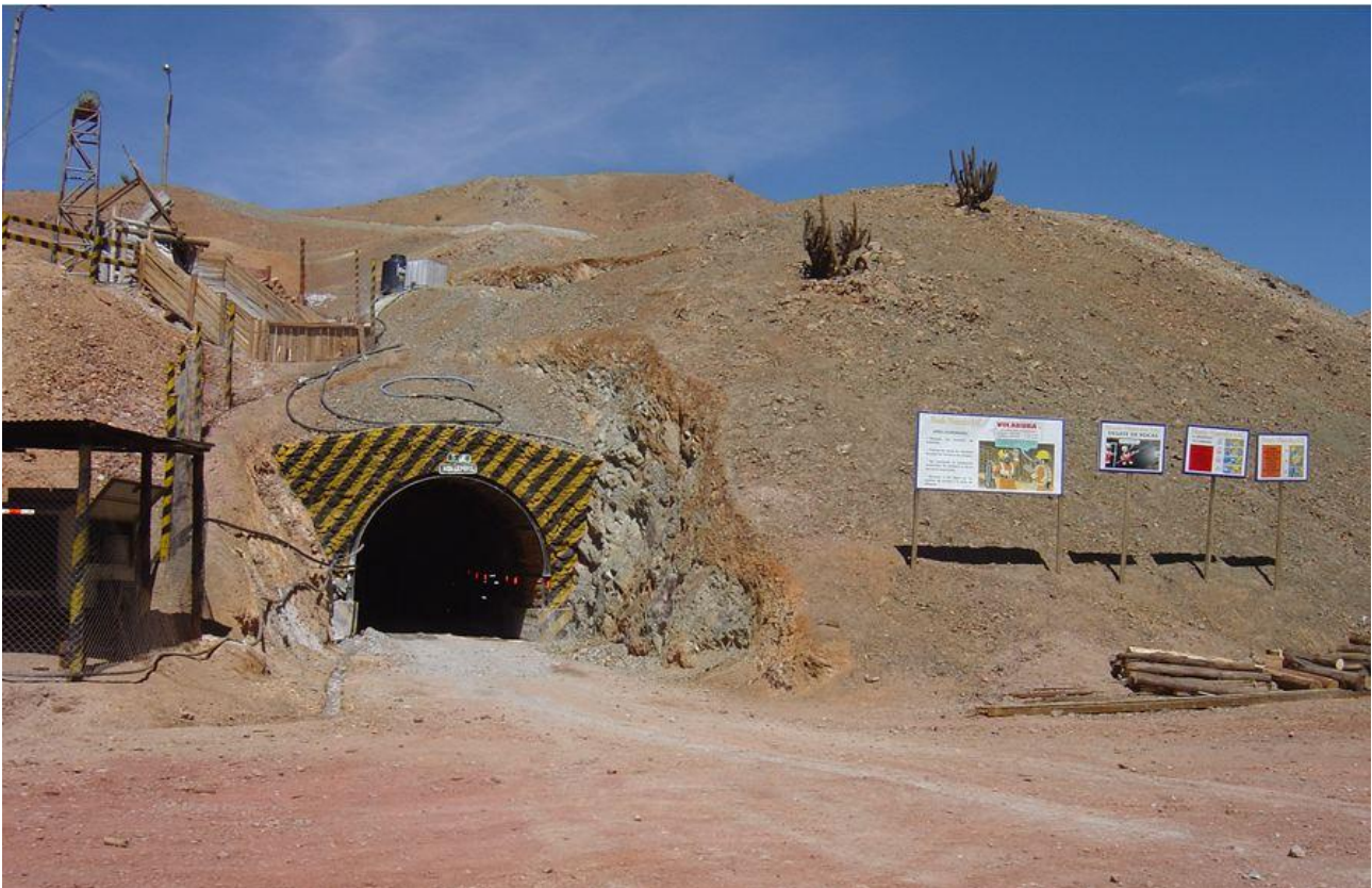
Access to the 5 Noviembre incline shaft and ore pass, Peru
