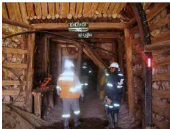
Figure 8 – Underground development, 5 Noviembre
